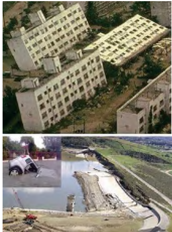
Gbr. 3. Kerusakan akibat Likuifaksi. sumber: Kramer (1966); Internet
