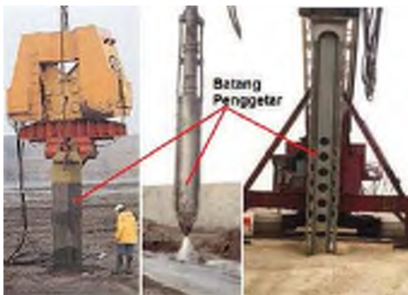
Gbr. 14. Ragam Batang Penggetar Vibro-Kompaksi.
