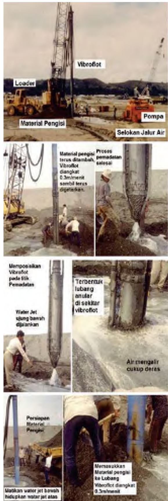
Gbr. 41. Proses Rangkaian Pelaksanaan Vibroflotation di Lapangan.
